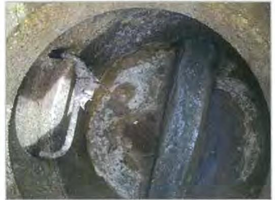
Le réseau amiante ciment 250 présente en revanche de nombreuses anomalies. On note la présence d'une vanne guillotine permettant la limitation des débits par by-pass au milieu naturel. Ce by-pass semble fermé. La question de l'utilité de ce by-pass se pose car un deuxième by-pass est présent quelques mètres plus loin. Les anomalies les plus récurrentes ou importantes sont les suivantes :
