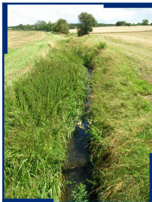
2 : "Les Dionnets" : vue vers l'amont du pont sur le lit mineur du ruisseau de la Loire
