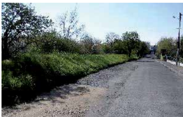
Digue de protection au niveau du stade
