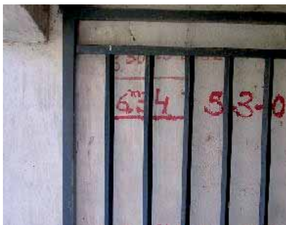
Repère de crues n°3 rue des remparts
