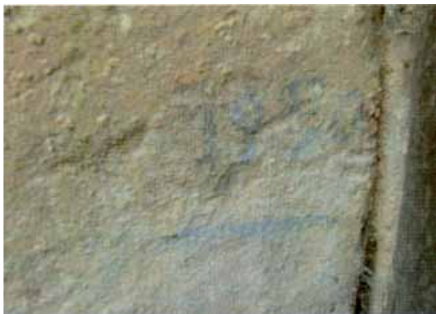
Repère de crues n°1 rue de la Cale
